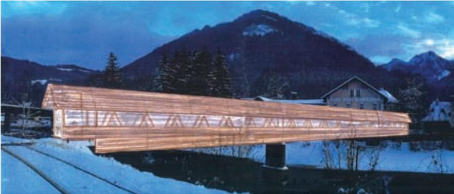
Die Brücke wird aus Holz mit einer Überdeckung gefertigt. Das soll die Haltbarkeit der Brücke entscheidend verlängern.
