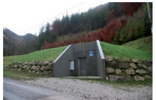
Der neue Hochbehälter mit moderner UV-Entkeimungsanlage im Tiessenbach.
