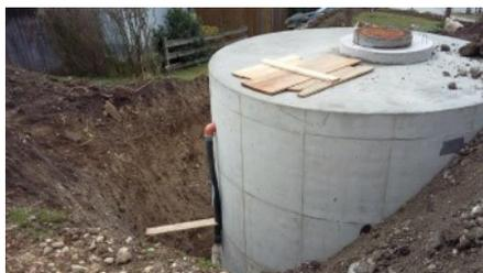
Der Einbau einer Regenwasserhausanlage ist eine nachhaltige Investition, wenn man Gutes für die Umwelt tun möchte. Das Regenwasser kann z.B. für die Toiletten-spülung und die Gartenbewässerung eingesetzt werden.
